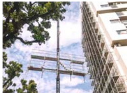
大組み・大バラシ工法
