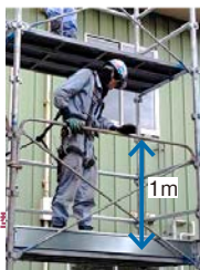
安心の手すり高さ1m
